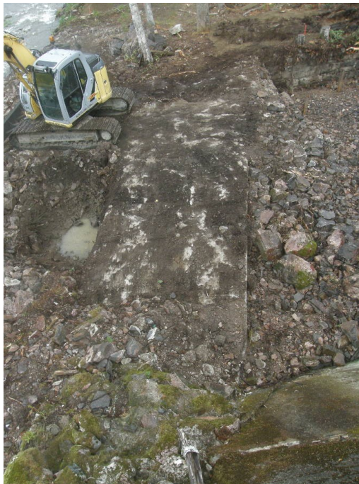
Kuva 25. Betonirakenne paljastettuna purkujätteen alta. Etualalla on oikealla näkyvän voimalapadon betoniluiskan vasemmalla puolella ja osittain alla vanhaa, rikottua betonirakennetta, jossa on täytteenä luonnonkiveä. Paljastettu betonirakenne on sen jatkoa ja ulottuu hiomarakennuksen länsipäätyyn, joka on ollut heti ensimmäisen kaivurin takana olevan puun ja oikealla näkyvän turbiinikammion alatilán takana. Kuvattu voimalapadon kulmauksesta itään.
