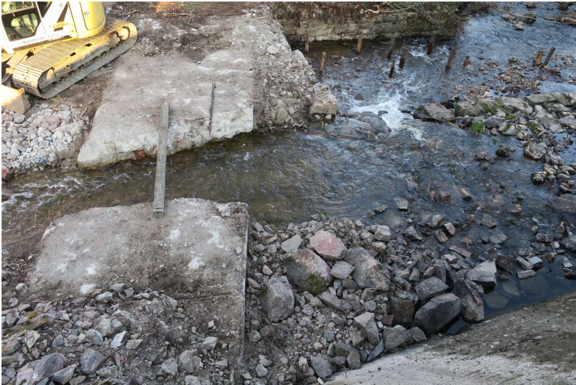
Kuva 26. Betonirakenne paremmin puhdistettuna. Rakenteen läpi on puhkaistu maisemointisuunnitelman mukainen kanaali, jonka kautta kosken luontaisesta uomasta virtaa vettä voimalan alapuoliselle vesialueella.
