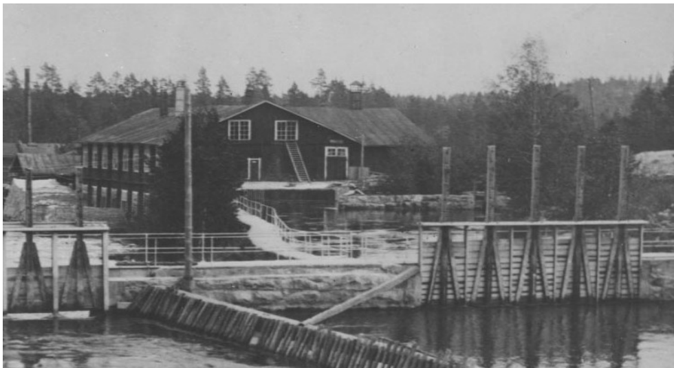
Kuva 33. Ylävesiallas, turbiiniosasto ja hiomon länsipääty lännestä nähtynä (osasuurennos kuvasta 3).
