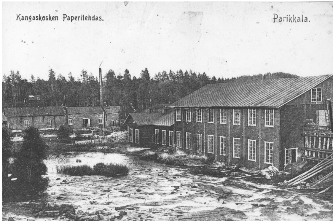
Kuva 2. Kangaskosken tehtaan rakennukset kuvattuna kosken pohjoisrannalta itäkaakkoon. Kuva on todennäköisesti otettu korkean rantatöyrään reunalta konttorina ja isännöitsijän asuntona toimineen talon pihapiiristä. Kuvan keskeltä oikealle on kaksikerroksinen puuhiomo. Jatkeena sen päädyssä ja osittain takana on vuonna 1906 rakennettu yksikerroksinen paperitehdas. Kuvan oikeassa reunassa näkyy osa hiomorakennuksen länsipäätyyn rajautuvasta turbiiniosastosta. Sen pohjoisseinässä on nähtävissä melko harvaan asetetuista pystyhirsistä muodostuva rakenne, jota ulkopuolelta tukevat muutamat vaakahirret. Etualalla on Kangaskosken luontainen uoma, jossa on kuvausajankohtana virrannut runsaasti vettä. Vesi ulottuu aivan tehdasrakennuksen perustusten lähelle. Paperitehtaan takaa pistää vasemmalle tehdassaaren koillinen niemenkärki, jonka ympäri joki laskee oikealle. Joen takana itärannalla näkyy rakenteeltaan kolmiosainen pannuhuone- ja kuivaamorakennus. Eteläisin ja lyhyin osa, joka osittain jää paperitehtaan ja rannalla olevien puiden taakse, on pannuhuone. Sen pohjoispään kohdalla näkyy pannuhuoneen takana oleva savupiippu. Pannuhuoneen vasemmalla puolella näkyy rakennuksen keskiosa, jonka kautta pahviarkit vietiin kuivaamoon. Osan keskellä näkyy avoin ovi, ja sen edustalla tehdassaaresta itärannalle tuleva silta. Rakennuksen pitkä pohjoisosa on kuivaamo, jota lämmitettiin pannuhuoneesta johdetulla höyryllä. Sen katolla näkyy piippumainen tuuletustorni, jonka kautta kostea ilma poistui kuivaamosta.
