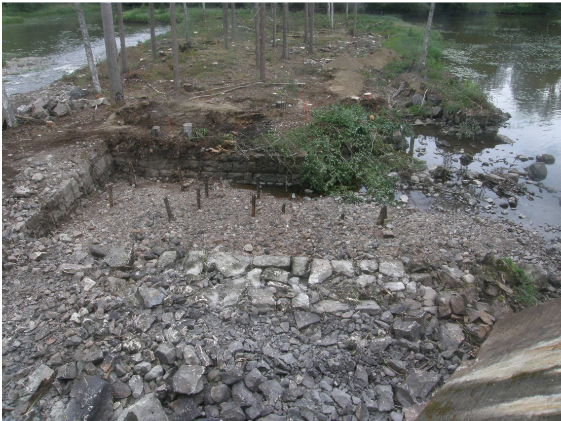
Kuva 22. Tehtaan päärakennuksen alue kuvattuna voimalapadolta itään. Kuvan keskellä näkyy turbiinikammion alla ollut tila, josta on poistettu purkujätettä lähes oikealla olevan alaveden pinnan tasoon asti. Tilaa rajaavat etualalla lännessä suurista kivistä kylmämuurattu seinä sekä pohjoisessa ja idässä lohkokivistä muuratut seinät. Tilan sisäosassa olevat tolpat ovat todennäköisesti olleet turbiinikammion lattian tukena. Turbiinien läpi valunut vesi on virrannut tilasta oikealle.
