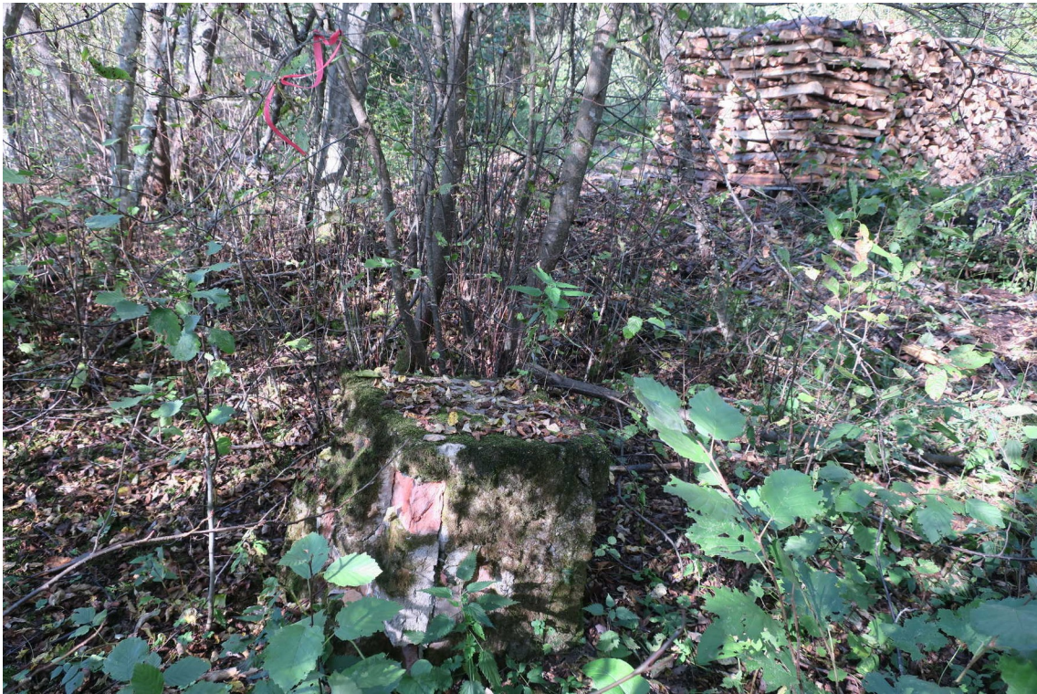
Kuva 28. Rajapyykki ja pensaikkoista maastoa pannuhuone- ja kuivaamorakennuksen alueella. Etualalla on kuutiomainen irrallinen kappale tiilimuurausta, todennäköisesti pannuhuoneen purkujätettä. Kappale on myöhemmin otettu uusiokäyttöön rajapyykkinä. Kuution pohjoissivulle (kuvassa kuution takana) on rapattuun pintaan uurrettuna rajapyykin numero ("2"). Taustalla näkyy halkopinoja, jotka ovat pannuhuone- ja kuivaamorakennuksen betonilattian päällä. Betonilattiaisen huoneen perustuksen lounaiskulma on halkopinon lähimmän kulman kohdalla. Kuvaussuunta koilliseen.
