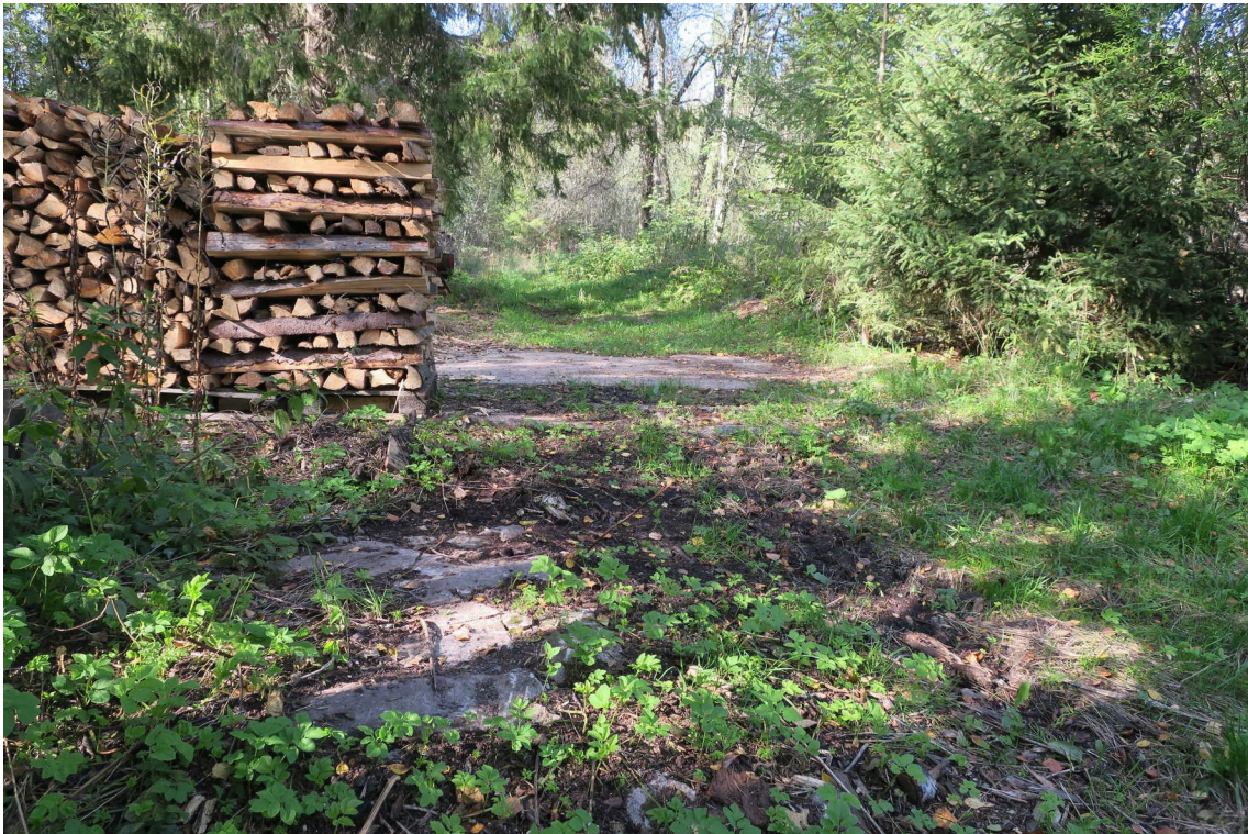
Kuva 29. Betonirakenne, ilmeisesti koneen alusta, pannuhuoneen pohjoisosassa. Taustalla näkyy betonilattia, joka on ilmeisesti rakennuksen keskiosan huoneessa. Huoneen eteläseinän perustus on halkopinon kuvaajan puoleisen reunan kohdalla.
