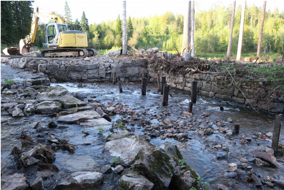
Kuva 23. Turbiinikammion alla ollut tila kuvattuna pohjoiseen. Tilan itäosassa on näkyvissä 12 rautatiekiskosta tehtyä metallitolppaa, joiden alapää on upotettu maaperään. Osa tolpeista on jonkin verran vinossa, mutta ne ovat saattaneet vääntyä niiden päällä olleiden purkujätteen lohkareiden painamina. Tolpat ovat todennäköisesti turbiinikammion lattian tukirakenteita. Turbiinikammion lattiataso on todennäköisesti ollut tilan perällä ja oikealla olevien kivistä muurattujen seinien päällä ja varassa. Vasemmalla olevan suurista kivistä rakennetun seinän yläpinta on alempana, mutta on mahdollista, että siitä on poistettu ainakin yksi kivikerros voimalan patoa rakennettaessa.
