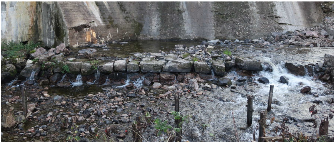
Kuva 24. Turbiinikammion alla olleen tilan suurista kivistä rakennettu länsiseinä. Etualalla näkyy tilan itäosassa olevia rautatiekiskosta tehtyjä metallitolppia. Taustalla on voimalapadon alaosa. Kuvaussuunta on länteen.
