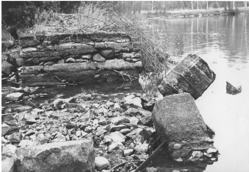
Kuva 19. Puuhiomon eteläisen lisärakennuksen eteläseinän alla olleet betonipylväät ovat etualalla ja lisärakennuksen perustus (numero 11 vuoden 2005 kartassa kuvassa 16) taustalla. Kuvattu itään. Kuvasajankohta on tuntematon.
