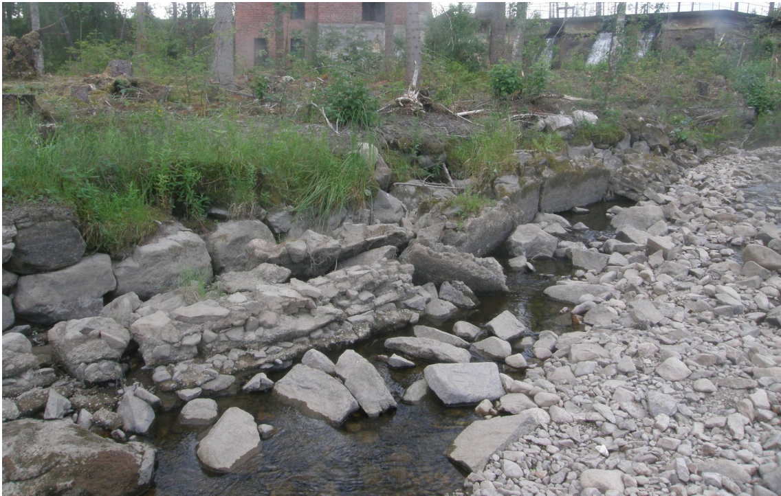
Kuva 17. Tehtaan päärakennuksen pohjoispuolella olevan terassimaisen tasanteen reunaa kuvattuna lounaaseen heinäkuussa 2021. Etualalla on tasanteen reunassa ollutta betonista ja täytteenä olevista luonnonkivistä valettua seinämää, joka on kaatunut joen pohjalle. Sen oikealla puolella on saman seinämän osa, joka ei ole vielä kaatunut. Kaatunut osa ei ollut näkyvissä vuonna 2005 korkealla olleen veden pinnan vuoksi. Oikealla on kosken kunnostustöissä paikalle levitettyä soraa ja taustalla voimalaitos.
