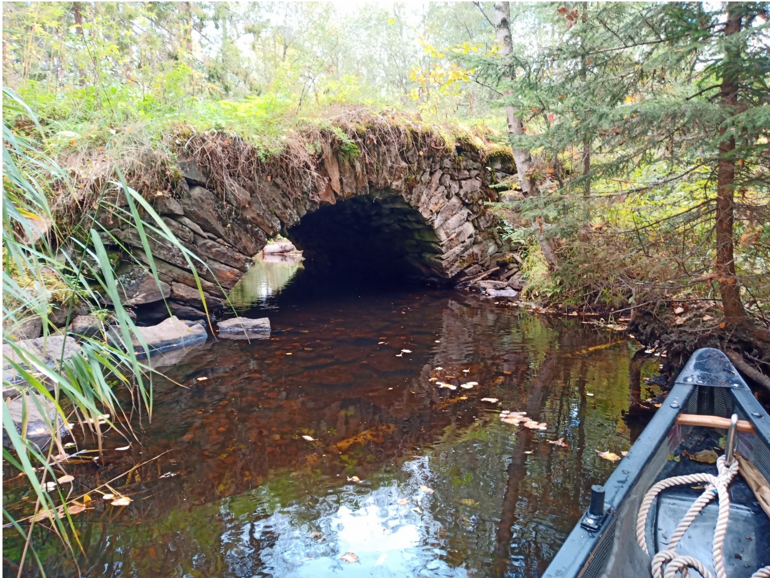
KUVA 16. Jokiosuuksille jäi monenlaisia siltojen alituksia. Yksi erikoisimmista on Romanan reitin ja Matkoreitin Vanhan Viipurintien holvattu kivisilta Myllyjoella, nähtävyys sinänsä. Myös vanhat rautatiesilta-aukot ovat täällä näyttäviä.
